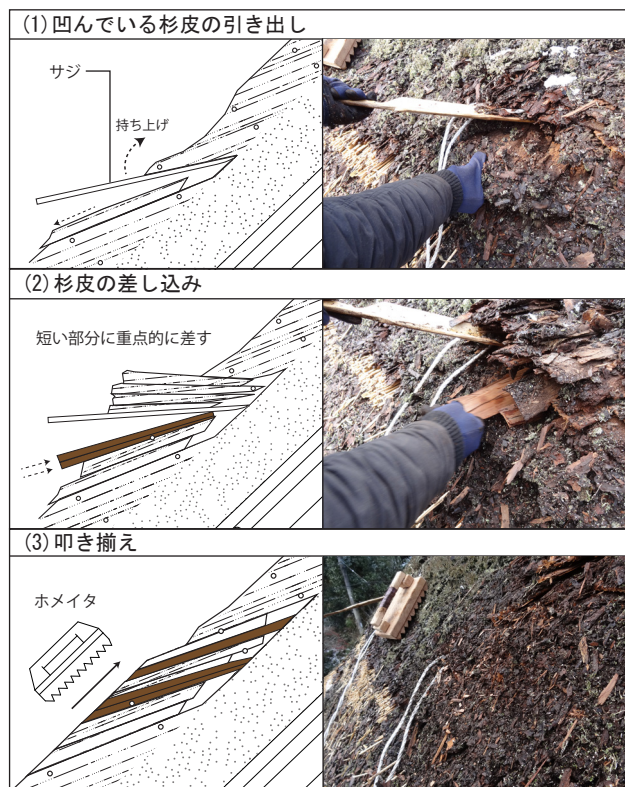
図7 凹凸均し工程
