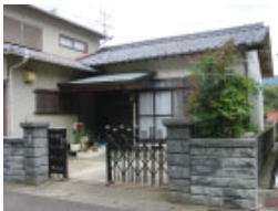
写真8 玄関も構えられた増築
