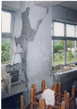
写真② 北村小学校の1階の柱
