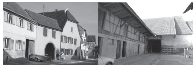
写真 3. 外観 (街道より)
